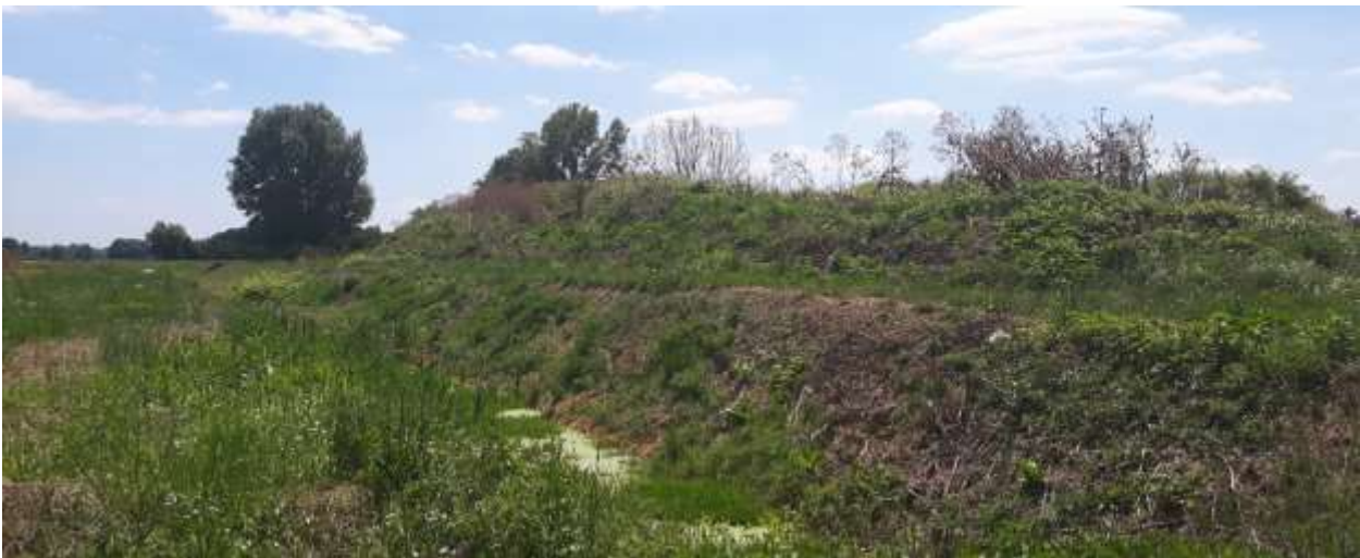
Strmi pokosi tijela odlagališta koji će se tijekom sanacije ublažiti
